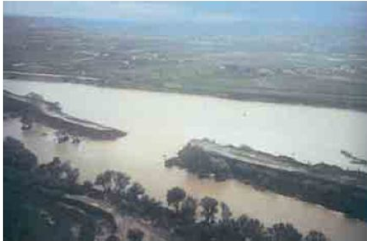
Figura 2.1.12: Rottura dell'argine dell'Arno in località "Roffia", ad ovest di Empoli. La rottura dell'argine, durante l'evento alluvionale del 20-21 ottobre 1992, laminò l'onda di piena abbassando il livello dell'acqua del fiume, a valle, di oltre un metro e mezzo.
