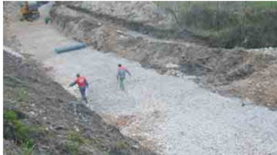
Figura 1.8.11: Posa del rivestimento di un alveo con materassi in rete metallica a doppia torsione riempiti in pietrame.
