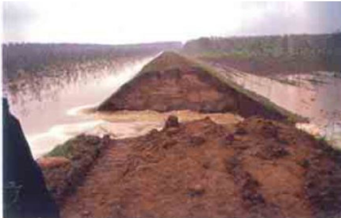
Figura 2.1.11: Rottura artificiale controllata per abbassare il livello della piena dell'argine di golena del fiume Po nel comune di Serravalle-Libiola in provincia di Mantova (alluvione ottobre 2000).
