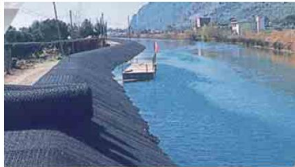
Figura 1.8.12: Fase di posa di geostuoia tridimensionale rinverdibile a difesa di una sponda.
